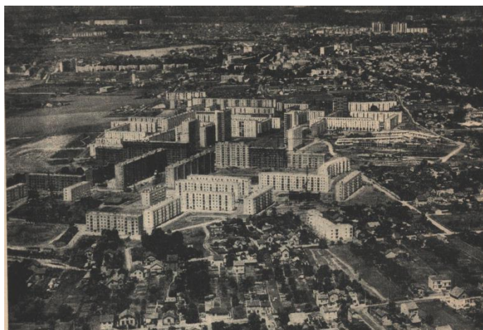
Hình 1.3. Khu nhà ở Creteil, Paris, Pháp [108]
