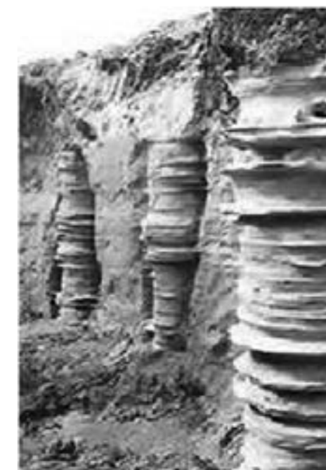
Hình 2. Hình ảnh các cọc xi măng đất được thi công theo công nghệ Jet Grouting (ở hồ thăm kỹ thuật)
