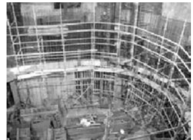
Hình 6. Chống thấm khe hở các hàng cọc xi măng - đất bằng màng ngăn pô-ly-me
