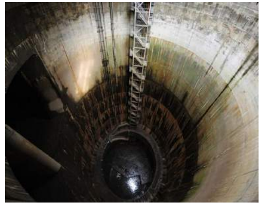
Hình 2-14 Giải pháp cống chung, bể ngầm có trữ lượng nước lớn để chống ngập tại Tokyo
