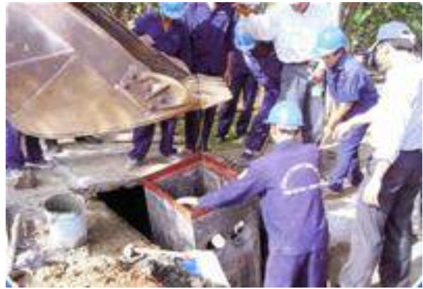
Hình 2-16 Thi công lắp đặt hệ thống ngăn mùi kiểu mới [Nguồn: Busadco]
