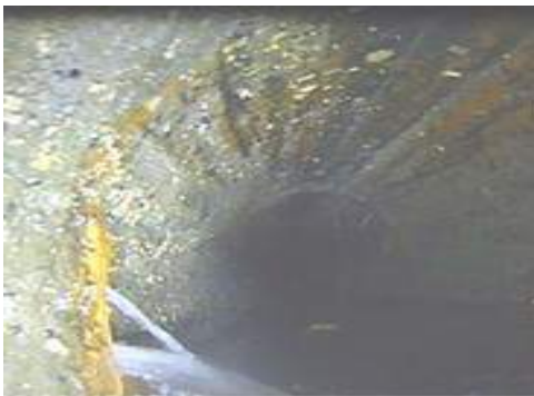
Hình 1-1 Phía bờ đường Hoàng Sa [28]
