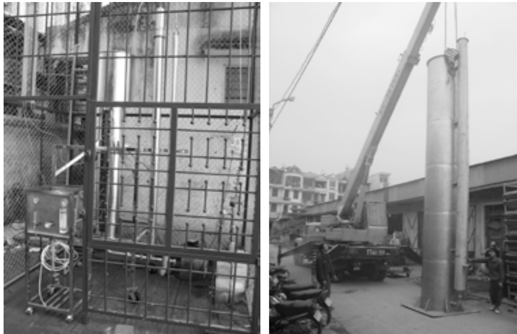
Hình 4. a- Mô hình pilot thử nghiệm xử lý nước ngầm công suất 15 m 3 /ngđ; b- Lắp ráp thiết bị xử lý nước ngầm tích hợp tự động thủy lực công suất 100 m 3 /ngđ.
