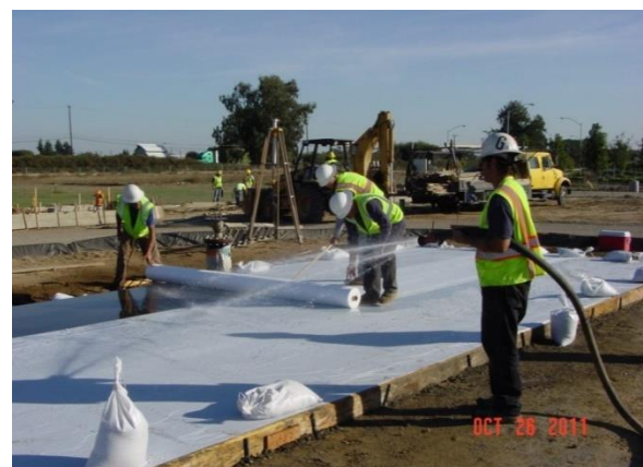
Hình 1.3. Bảo dưỡng bên ngoài (EC) mặt đường BTXM
