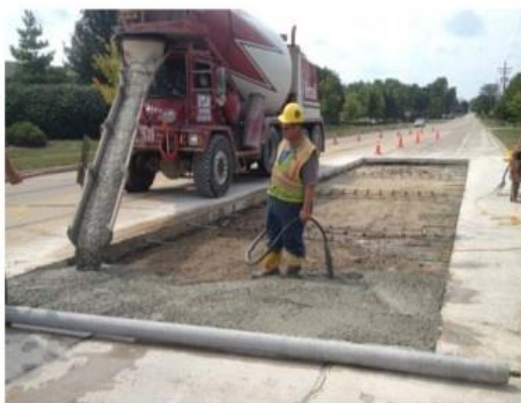
Hình 1.2. Mặt đường BTXM nội bảo dưỡng
