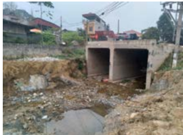
Hình 8. Công hóa hệ thống sông suối tại Tp Lào Cai [2]
