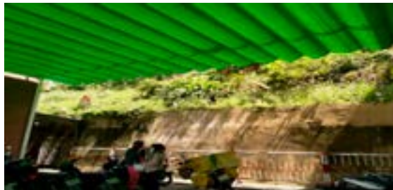
Hình 9. Mái dốc đã được xử lý theo phương pháp “đỉnh đất”, phần tường bê tông dưới dày 10cm, nửa trên được bảo vệ bằng các ô địa kỹ thuật để trồng cỏ tạo thành thảm bảo vệ. Hình ảnh chụp năm 2023 tại số 33 Nguyễn Văn Cừ, Phường 1, thành phố Đà Lạt [6]
