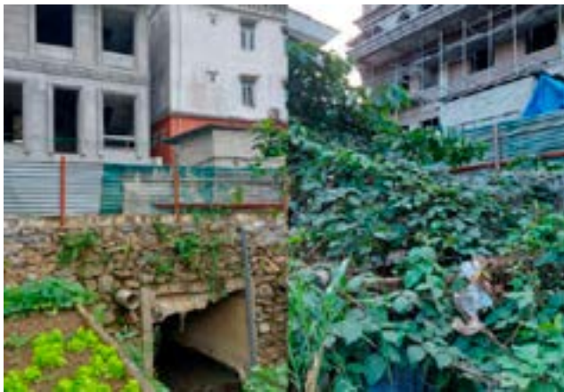
Hình 7. Xây dựng công trình lấn chiếm hành lang thoát nước tại Tp Hà Giang [2]
