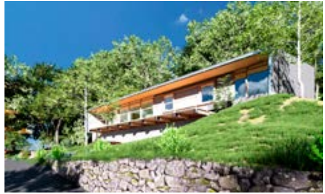
Hình 12. Gia cố mái taluy bằng đá xếp khan kết hợp trồng cỏ
