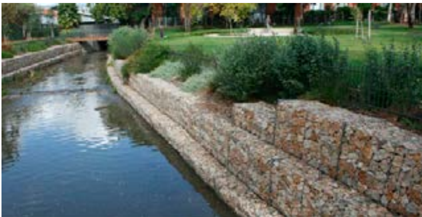
Hình 13. Gia cố bờ suối bằng rọ đá kết hợp trồng cỏ
