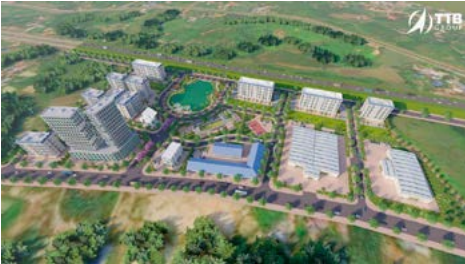
Hình 2. Dự án nhà ở xã hội phường Tích Lương, thành phố Thái Nguyên, tỉnh Thái Nguyên
