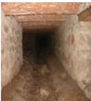
Hình 1.6. Tầng hầm một công trình thuộc địa tại Hà Nội
