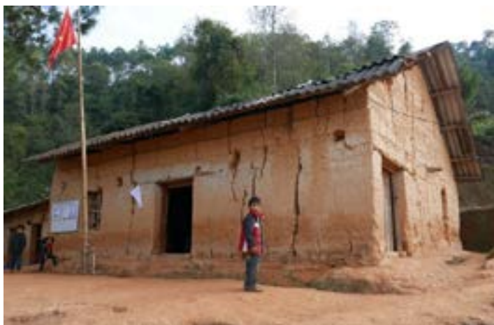
Hình 21. Thực trạng nhà trình tường nứt xuyên tường[5]
