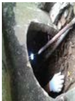
Hình 1.7. Lỗ vào tầng hầm một công trình thuộc địa tại Hà Nội
