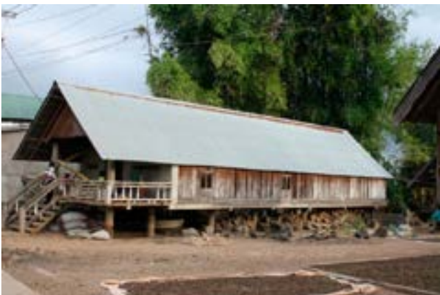
Hình 16. Mái lợp tôn[5]
