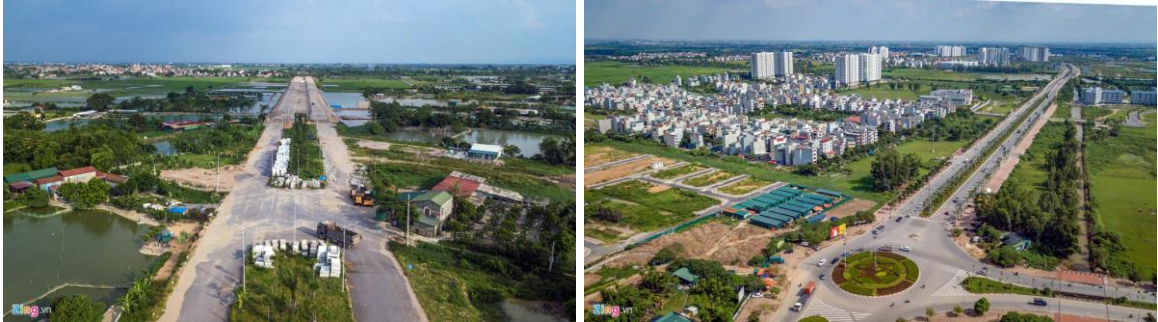
Hình 1.8, 1.9: Dự án đường trục phía nam Hà Nội - Đoạn Kiến Hưng - Cầu Giẽ
