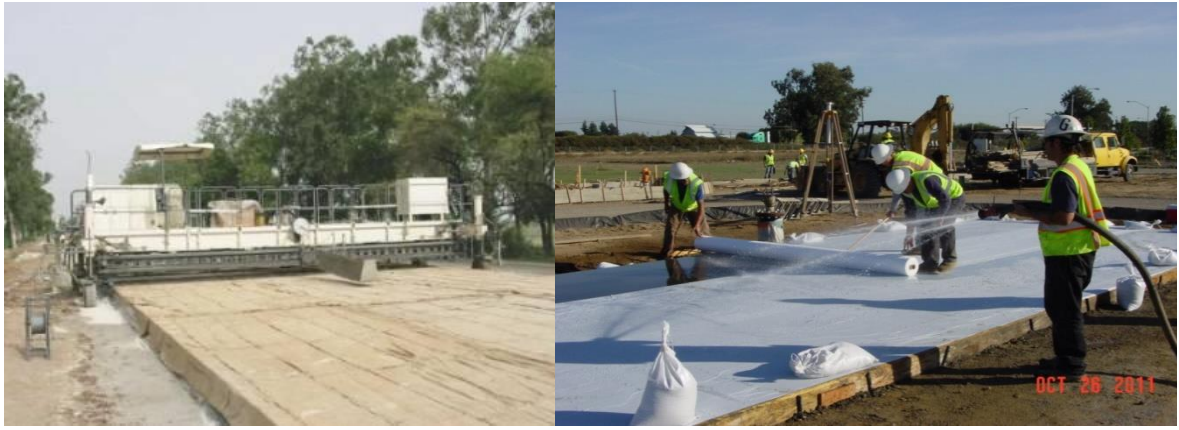
Hình 1.3. Bảo dưỡng bên ngoài (EC) mặt đường bê tông xi măng [12]
