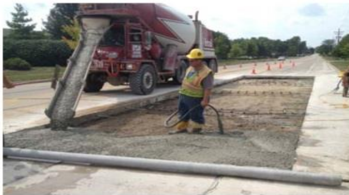
Hình 1.2. Mặt đường BTXM nội bảo dưỡng [54]
