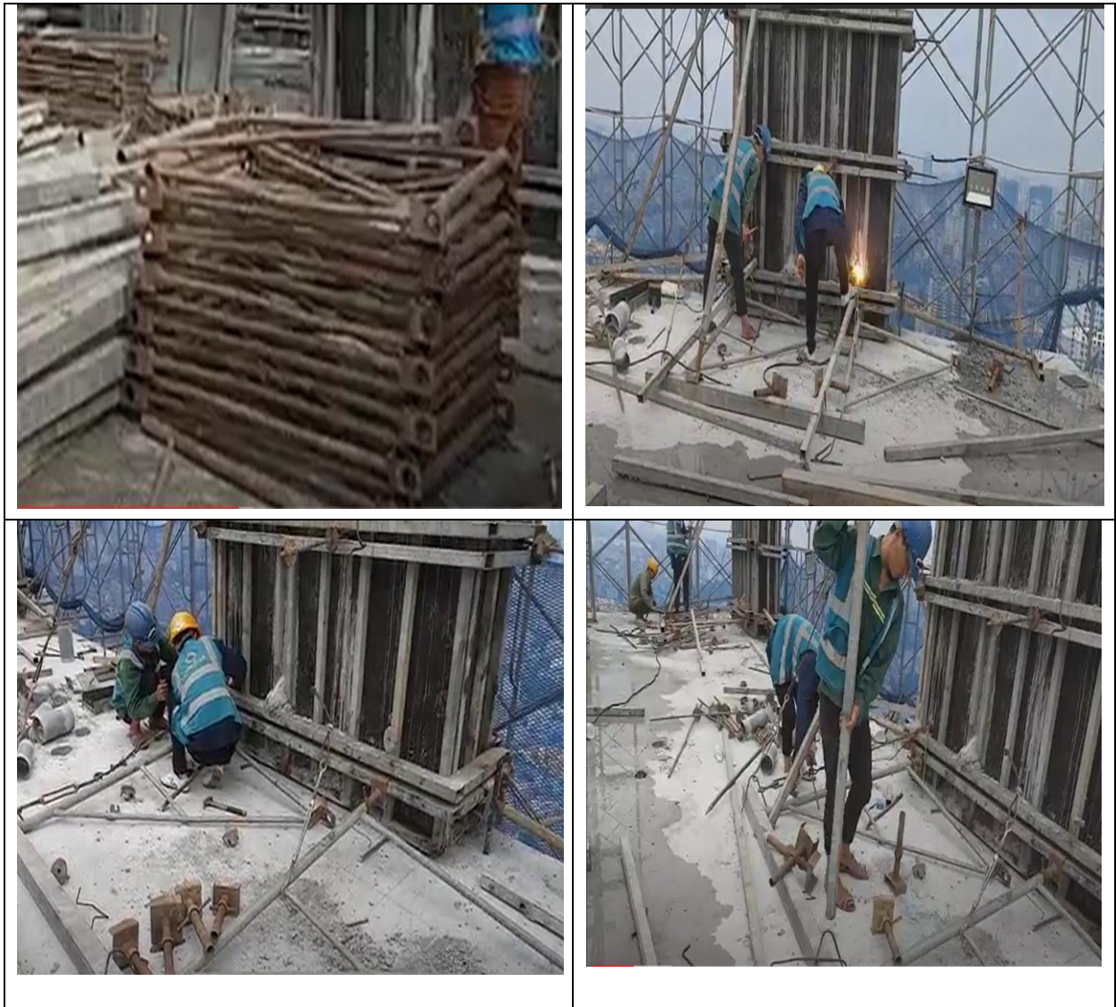
Hình 4.15 Một số hình ảnh lắp dựng ván khuôn cột sau khi áp dụng JIT được ghi lại
