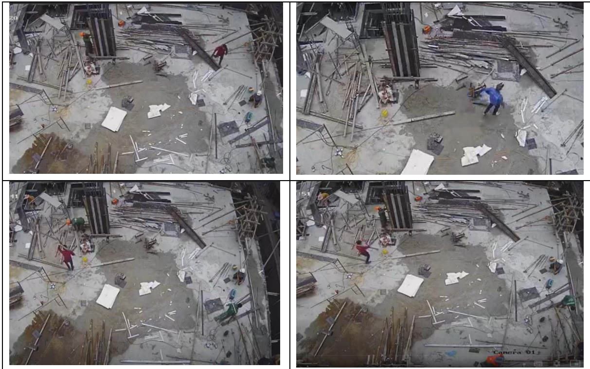
Hình 4.12: Một số hình ảnh lắp dựng ván khuôn cột trước khi áp dụng JIT được ghi lại
