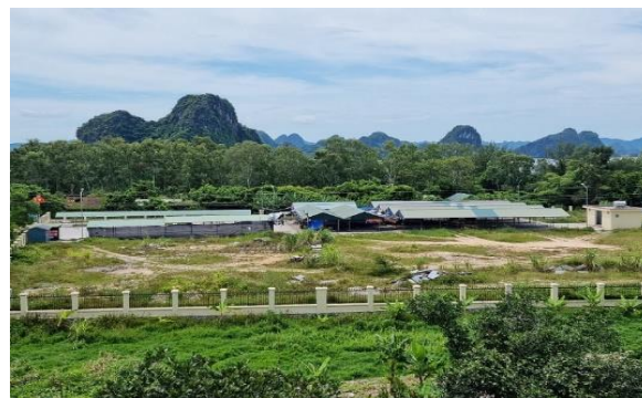
Hình 1.20. Chợ xã Đông Xá, huyện Vân Đồn công trình xây dựng không còn phù hợp với nhịp độ phát triển kinh tế - xã hội ở địa phương.
