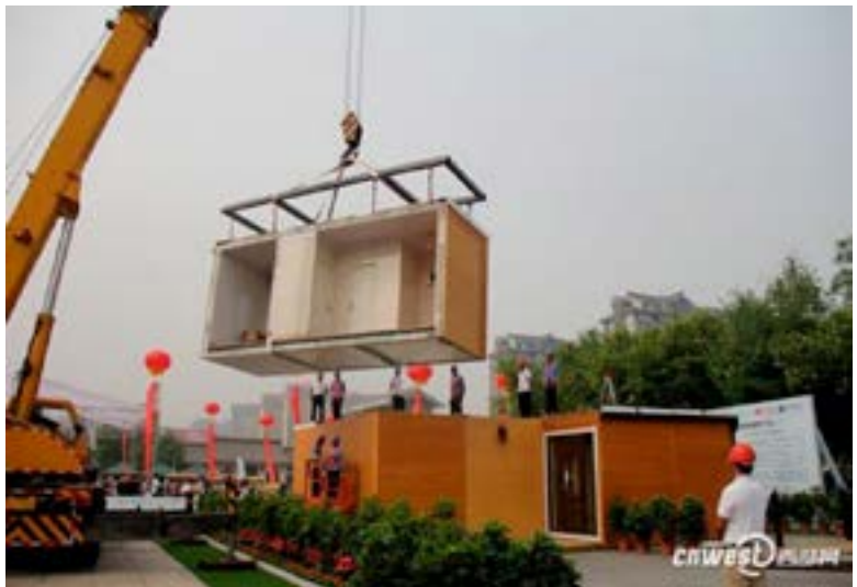
Hình 2. Nhà ở 2 tầng thực hiện in 3D (CHND Trung hoa)
