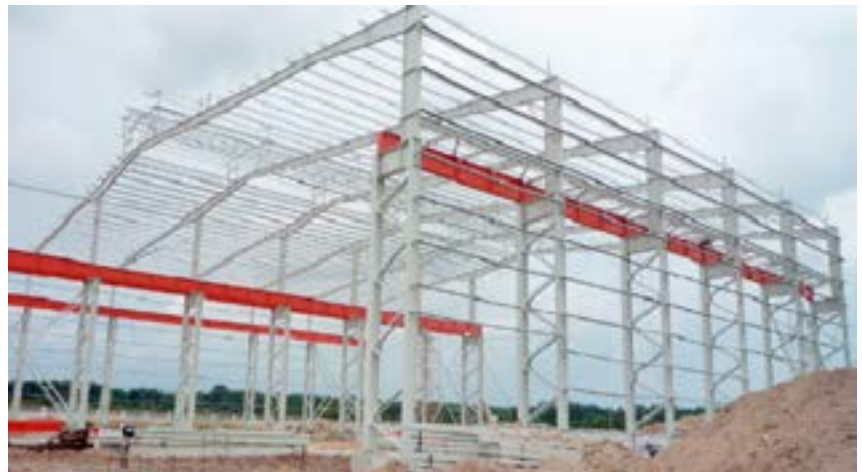
Hình 1. Kết cấu cột rỗng 2 nhánh
