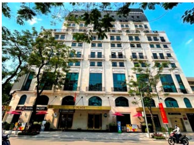
Hình 7. Chung cư 30A Lý Thường Kiệt là một điển hình của việc tái thiết chung cư cũ trở thành một tòa nhà khang trang, hiện đại. (Nguồn Internet)
