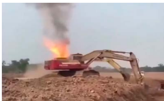
Hình 2 – Máy xúc bốc cháy do rò rỉ xăng và chập hệ thống điện. Nguồn: internet, tháng 8/2021
