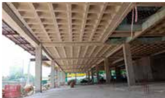
Hình 1.1. Sàn ô cờ bố trí lưới đều nhau vuông góc [arch.vn]
