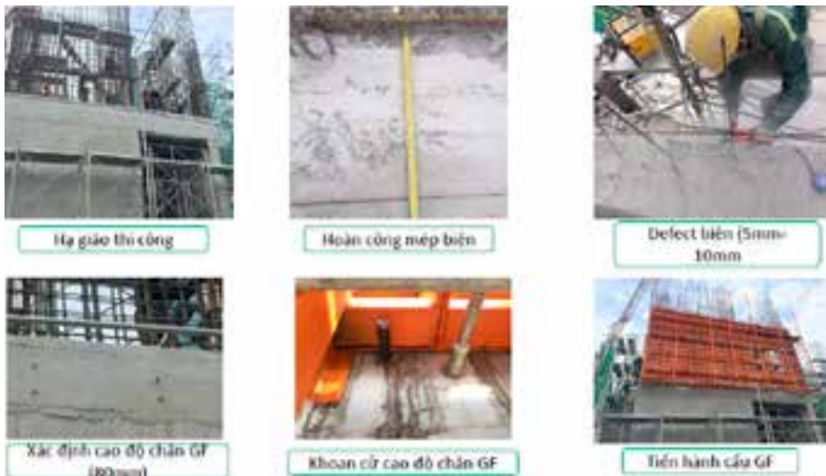
Hình 4. Quá trình chuẩn bị và lắp Gang form
