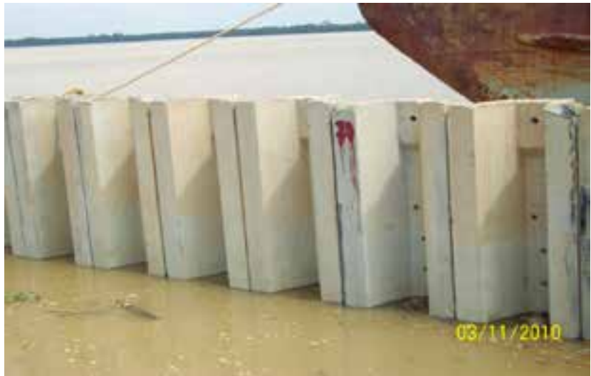
Hình 6. Cọc ván ứng lực trước dạng sóng
