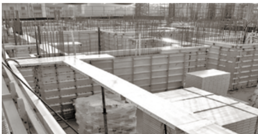
Hình 1.1. Hình ảnh thi công ván khuôn nhôm tại dự án Hyundai HillState
