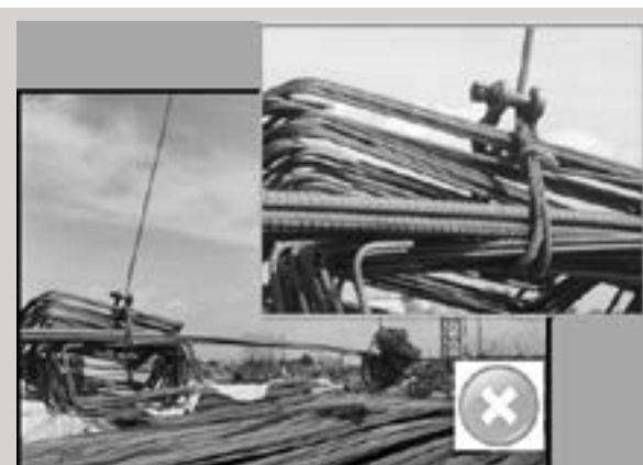
Hình 8. Yêu cầu khi móc cáp, ma ní
