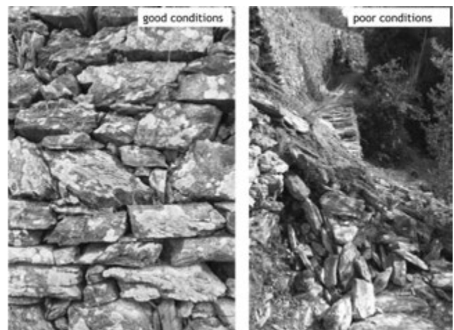
Hình 5. Hình ảnh của kè đá tình trạng tốt (trái) và tình trạng xấu (phải) [5]
