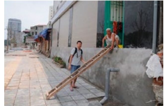
Hình 2: Cốt nền công trình cao hơn cốt mặt đường ở trục đường Nguyễn Văn Huyền từ 0,5m - 1,5m (Nguồn Internet)
