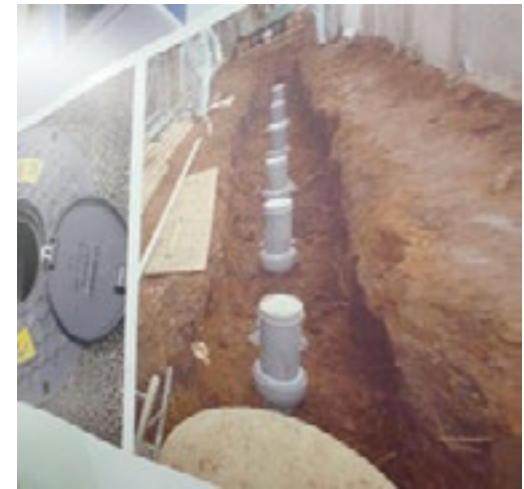
Các giếng thăm tại vị trí đầu nối với thiết bị thải nước
