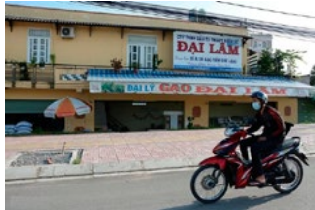
Hình 1: Cốt nền công trình thấp hơn cốt mặt đường ở trục đường Kinh Dương Vương từ 1,0m - 1,2m (Nguồn Internet)
