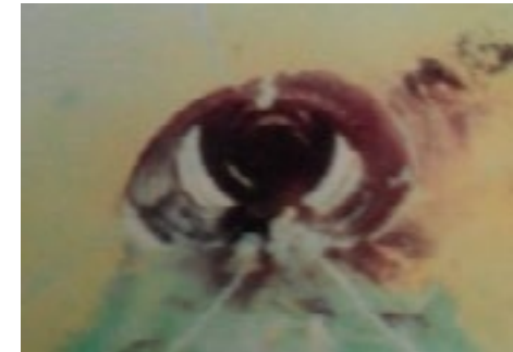
Cống bị biến dạng
