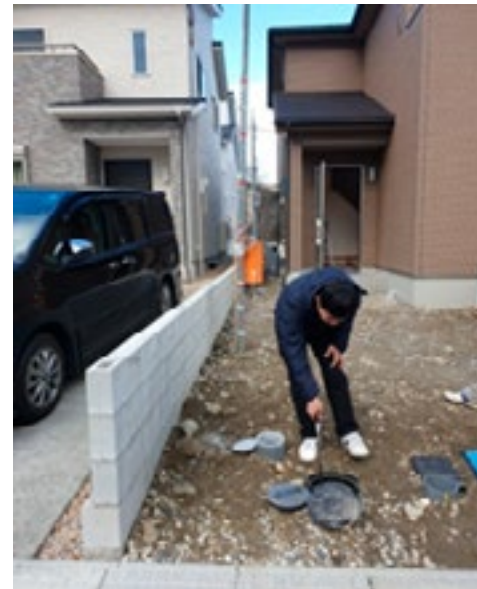
Hình 2.3. Hình ảnh về giếng thăm để quản lý bảo dưỡng thiết bị thải nước[3]
