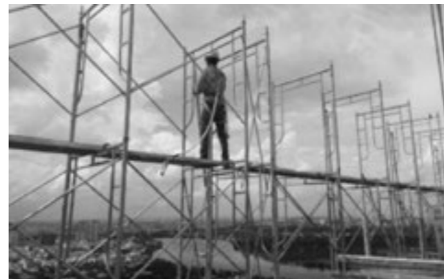
Hình 7. Hình ảnh lắp dựng giàn giáo bao che
