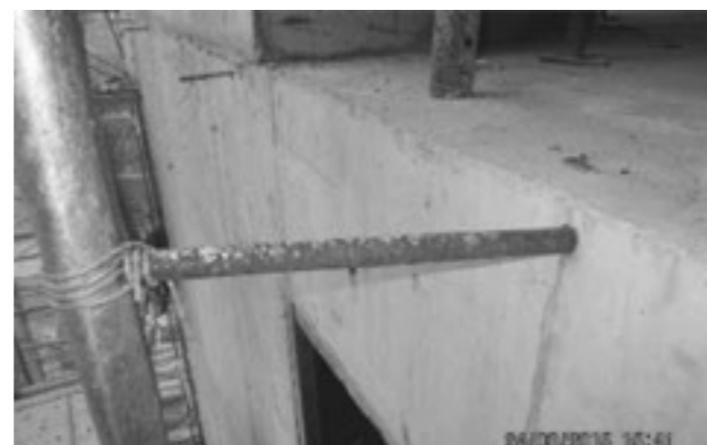
Hình 10. Chi tiết neo giàn giáo vào công trình
