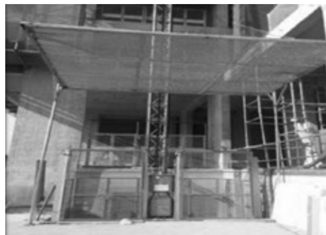
Hình 15. Lưới hứng vật rơi tại vị trí thang tải, thiết lập lưới bên trên lối vào
