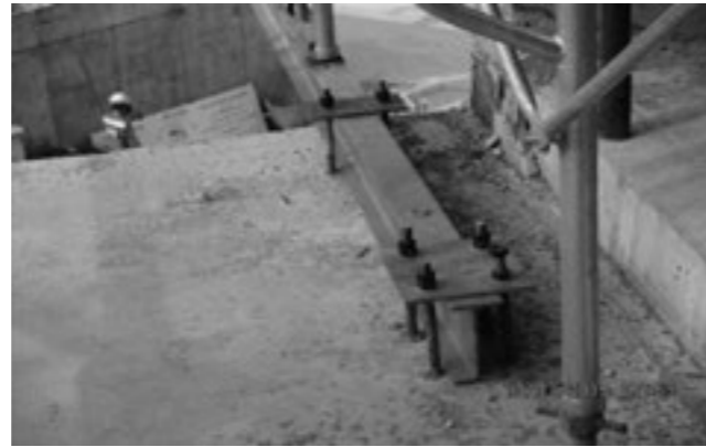
Hình 12. Hình ảnh dầm I dạng console nằm trên sàn bê tông
