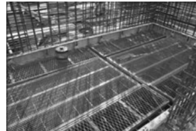
Hình 20. Đặt các tấm sàn công tác
