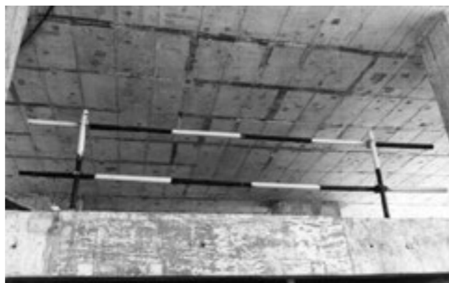
Hình 4. Lan can bằng tuýp vàng đen
