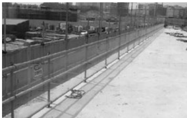
Hình 3. Lan can được bắt lên sàn bê tông
