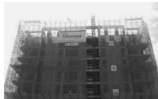
Hình 8. Hệ lưới bao che công kiểu quả trám
