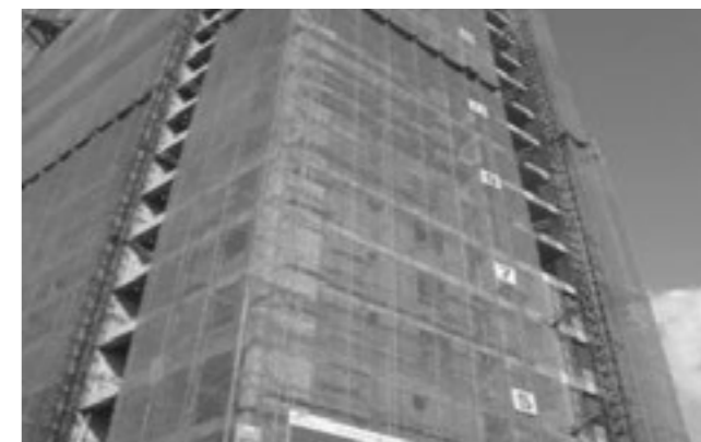
Hình 9. Hình ảnh hệ lưới bao che công kiểu caro
