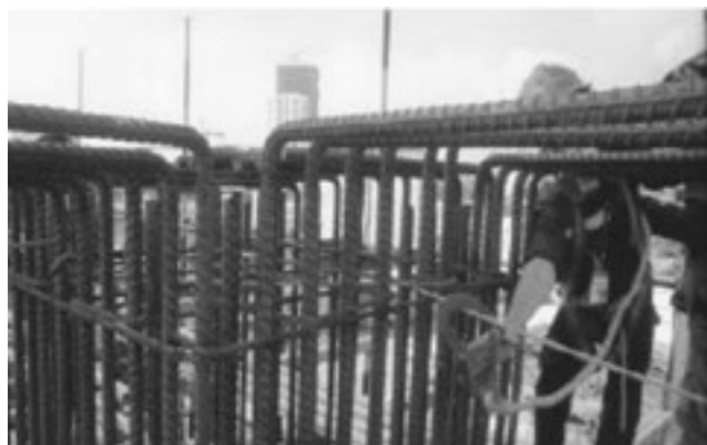
Hình 1. Thiết lập dây cứu sinh
