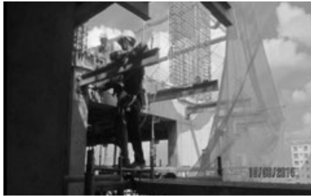
Hình 11. Hình ảnh dầm I dạng console bắt trên ngoài sàn
