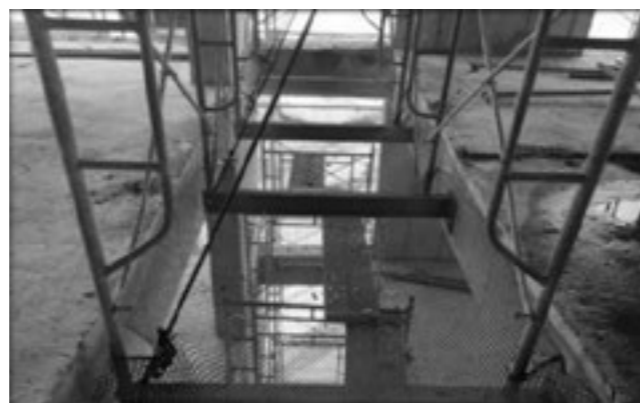
Hình 17. Lưới hứng tại lỗ mở trong nhà, khung lưới che chắn lỗ kỹ thuật
