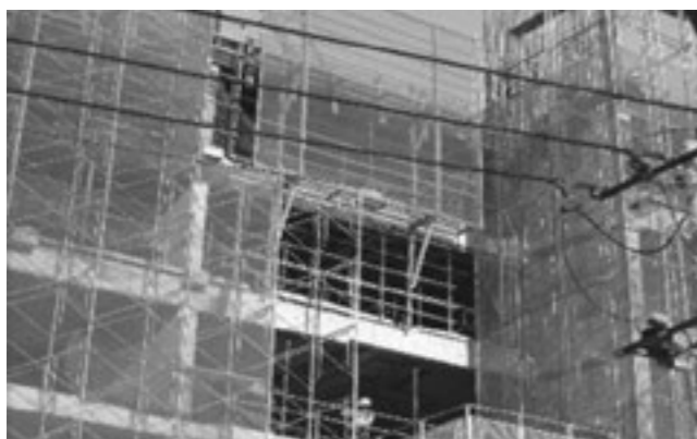
Hình 16. Vị trí sàn tiếp liệu, bên trên phải thiết lập hệ giáo trượt
