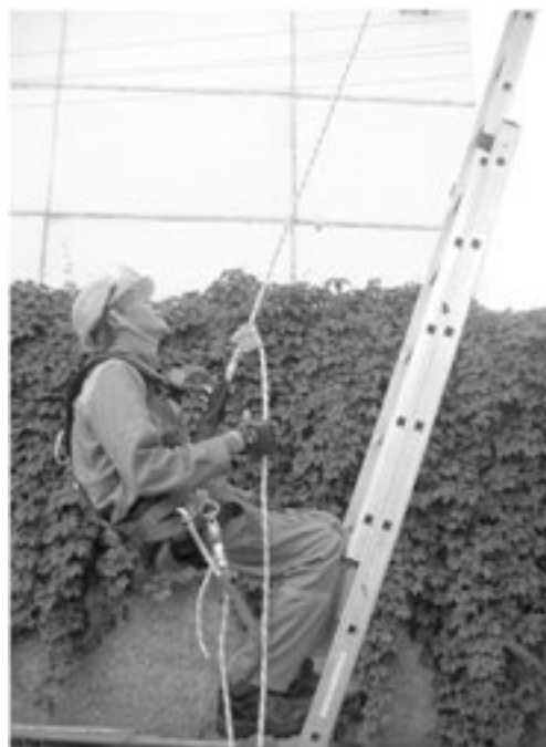
Hình 7. Công nhân sử dụng hệ thống dây neo an toàn khi thi công
