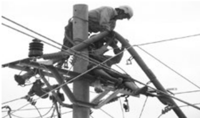
Hình 5. Thiếu trang bị an toàn cá nhân
