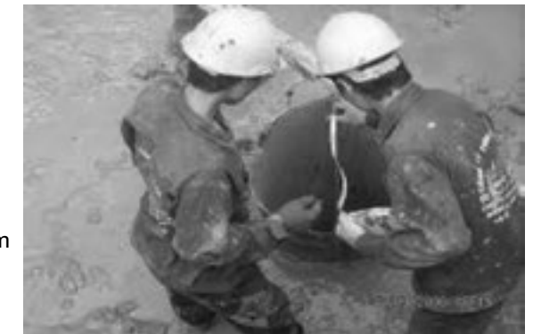
Hình 5. Kiểm tra độ sâu hố khoan
