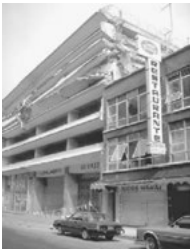
Hình 15. Hiện tượng phá hoại dẫn đến đổ xếp chồng của các tầng trên tầng gara do trận động đất Michoacan ở Mexico vào ngày 19-9-1985. Nhà hàng bên cạnh đã tạo thành gối tựa tầng cường khả năng chống lực ngang giúp các tầng dưới của gara đổ xe chống lại sự phá hoại
