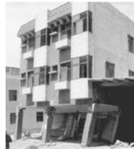
Hình 5. Hư hỏng do tầng mềm ở tầng trệt. Sự hư hỏng xảy ra do trận động đất Chi-chi ở Đài Loan vào ngày 21-9-1999
