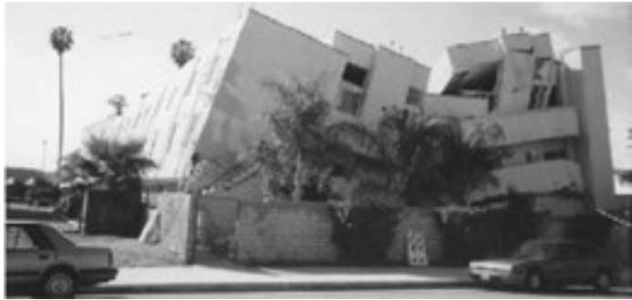
Hình 6. Toà nhà sụp đổ, nguyên nhân do sử dụng tầng thứ nhất làm gara đỗ xe tạo thành một tầng mềm
