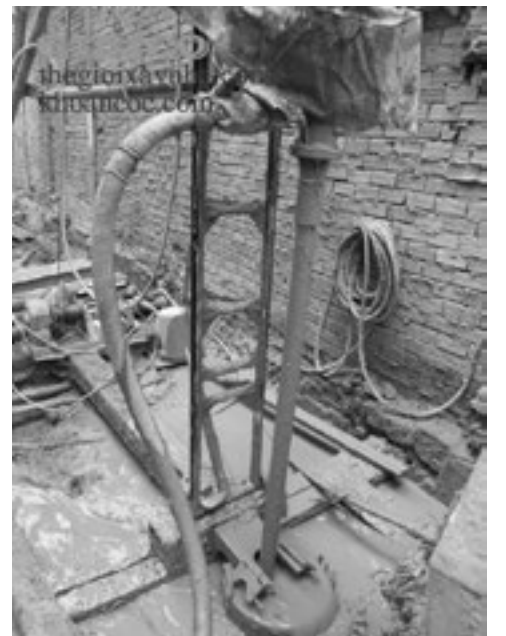
Hình 1. Thi công cọc khoan nhồi đường kính nhỏ
