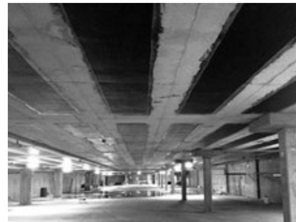
Hình 3: Thi công “dán bề mặt” Vật liệu FRP – gia cường sàn (nguồn internet)
