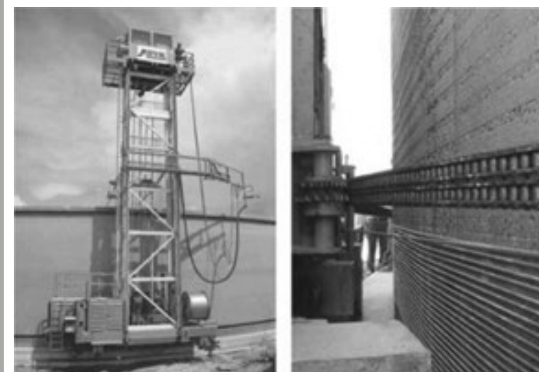
Hình 1: Thi công cấp ứng suất trước trong bể chứa
