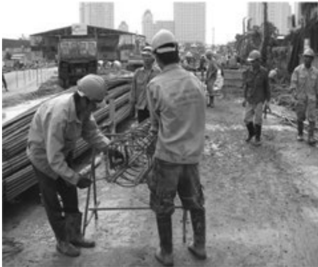
Hình 7. Gia công lồng thép
