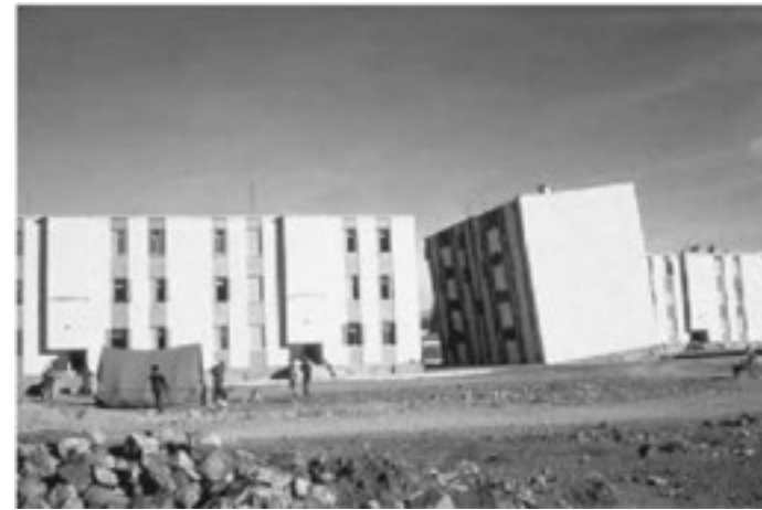
Hình 9. Toà nhà bị nghiêng và hư hỏng với nguyên nhân bởi tầng mềm do sử dụng không gian tầng trệt trống để thông gió và cách ẩm
