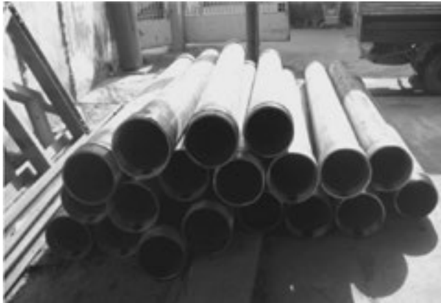
Hình 6. Ống thép đổ bê tông
