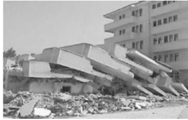
Hình 14. Hiện tượng phá hoại dẫn đến đổ xếp chồng do trận động đất ngày 17-8-1999 ở Izmit, Thổ Nhĩ Kỳ
