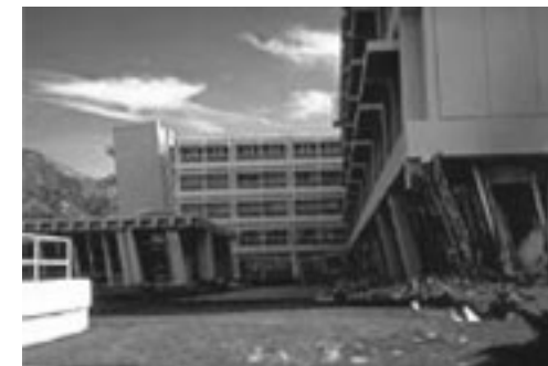
Hình 9. Toà nhà bị nghiêng và hư hỏng với nguyên nhân bởi tầng mềm do sử dụng không gian tầng trệt trống để thông gió và cách ẩm
