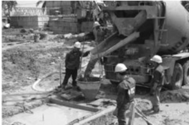
Hình 10. Đổ bê tông cọc nhồi
