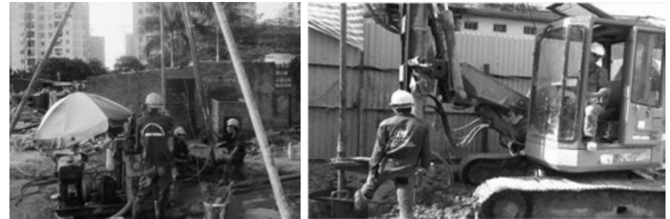
Hình 3. Thiết bị khoan cọc nhồi – Cần khoan tháo lắp, Cần khoan tự hành
