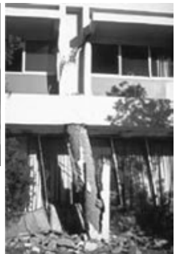
Hình 10. Dạng phá hoại của tầng mềm nằm ở tầng giữa công trình. Sự không liên tục của các vách cứng là nguyên nhân tạo nên tầng mềm
