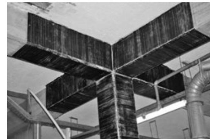
Hình 4: Thi công “dán bề mặt” Vật liệu FRP – gia cường dầm (nguồn internet)
