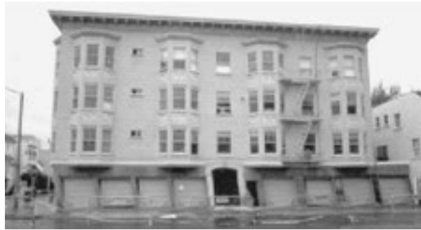
Hình 7. Hư hỏng do sử dụng tầng thứ nhất làm gara đỗ xe tạo thành một tầng mềm. Hư hỏng xảy ra do trận động đất Loma ở California vào ngày 19-10-1989
