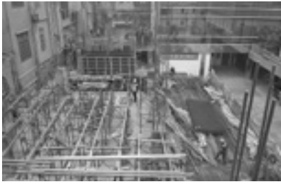
Hình 5. Lắp dựng hệ cột chống, đà giáo và ván khuôn cho sàn U-Boot Beton
