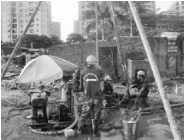
Hình 1. Thiết bị khoan cọc nhồi – Cần khoan tháo lắp, Cần khoan tự hành
