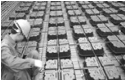
Hình 7. Lắp đặt hộp nhựa cho sàn U-Boot Beton
