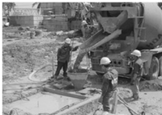
Hình 7. Đổ bê tông cọc nhồi
