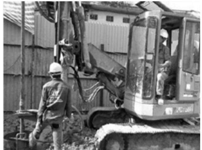
Hình 1. Thiết bị khoan cọc nhồi – Cần khoan tháo lắp, Cần khoan tự hành
