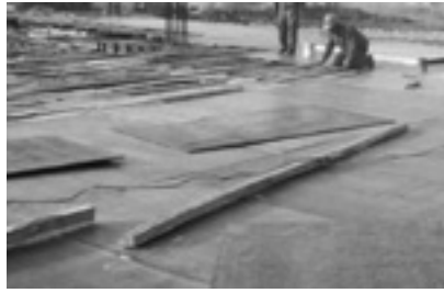
Hình 5. Lắp dựng hệ cột chống, đà giáo và ván khuôn cho sàn U-Boot Beton
