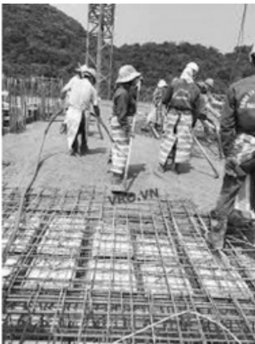
Hình 4.2. Đồ bê tông sàn
