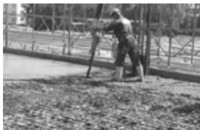
Hình 11. Đổ bê tông lần 2
