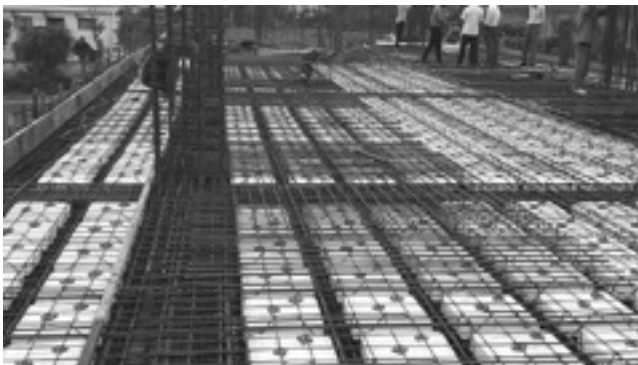
Hình 4.1. Lắp dựng cốt pha, cốt thép sàn
