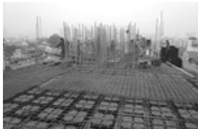
Hình 7. Lắp đặt hộp nhựa cho sàn U-Boot Beton
