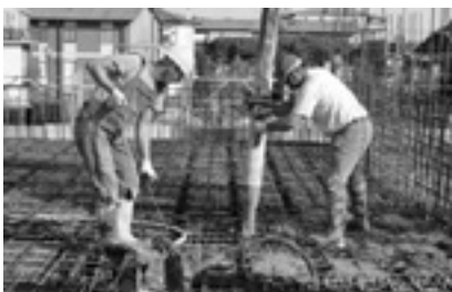
Hình 10. Đổ bê tông lần 1
