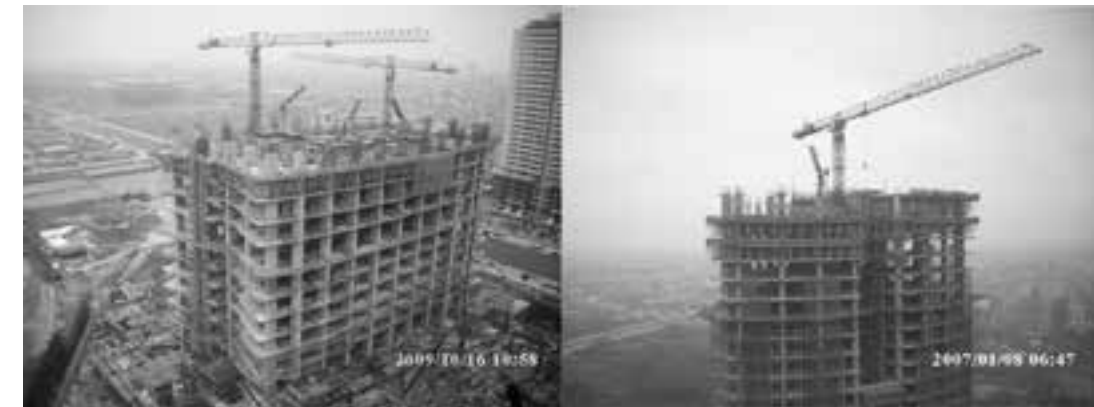
Hình 4. Cần phân phối bê tông dự án Keangnam Hanoi Landmark Tower
