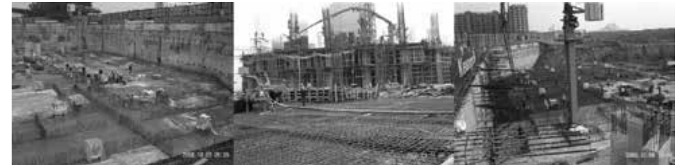
Hình 3. Cần phân phối bê tông dự án Keangnam Hanoi Landmark Tower
