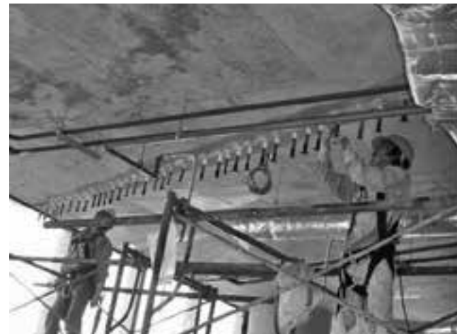
Hình 17. Bơm keo epoxy từ đáy sàn
