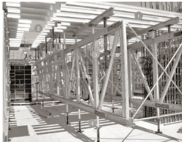
Hình 6. Hệ thống cốp pha bàn (Table Form)
