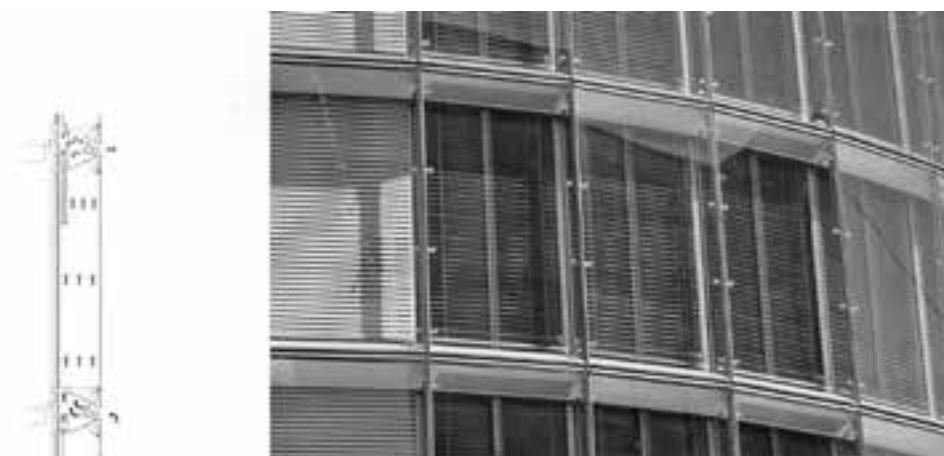
Hình 2. Công trình trụ sở chính RWE AG tại Essen
