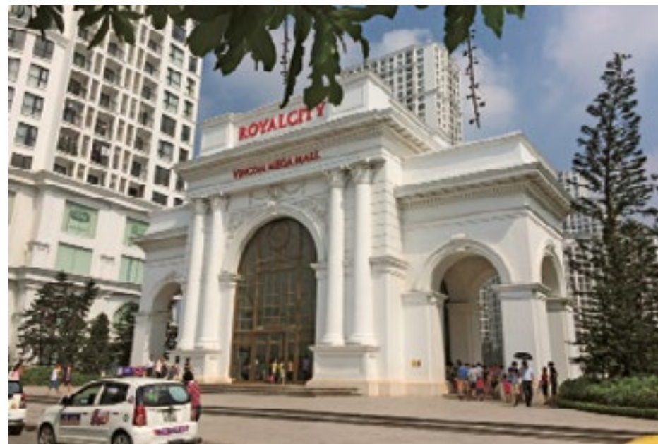
Hình 4. Lối vào Vincom Mega Mall ngầm của Royal City, Hà Nội chưa tạo được dấu hiệu tương xứng với quy mô và đặc tính của không gian thương mại rộng lớn cao hai tầng phía dưới. Vấn đề chiếu sáng tự nhiên chưa được xử lý.
