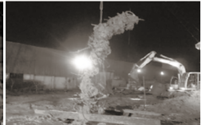
Hình 7. Lồng thép bị hư hỏng trong quá trình cầu hạ lồng - Dùng máy đào HS855 lấy lồng thép lên
