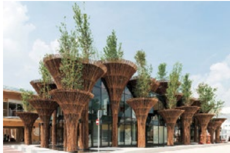
Hình 3. Công trình triển lãm của Việt Nam World Expo 2015 tại Milan, Italia
