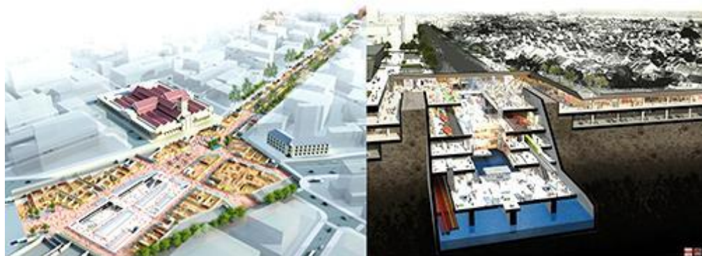
Hình 3.PL3:Tổ hợp ga Metro Bến Thành (TP.HCM). Hà Nội bao gồm Ga ngầm, trung tâm thương mại, bãi đỗ xe ngầm, và hệ thống xử lý, thoát nước [36].
