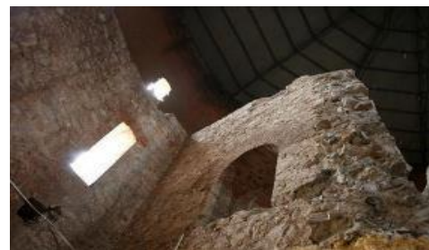
Hình 5. Những bể đỡ bể nước bằng đá đã và đang bị ăn mòn theo thời gian
