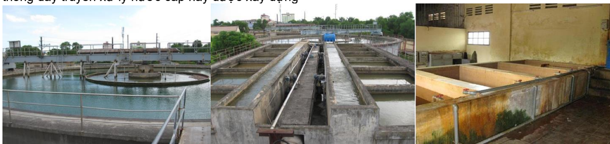
Hình 2.2. Một số công trình xử lý của nhóm II (Bể lắng radian, bể lọc vật liệu nổi, nhà hóa chất)
