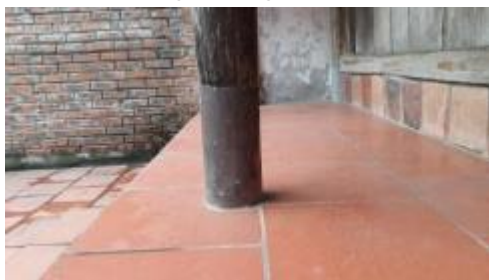
Hình 10. Cột xiên đã được làm mới lại phần chân bằng bê tông (không đúng so với quy định)
