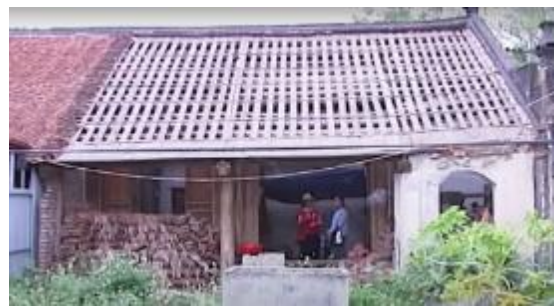
Hình 13. Nhà bà Thảo trong quá trình tu bổ không có bất kì hệ thống che chắn nào để bảo vệ các cấu kiện khi tháo dỡ.
