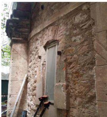
Hình 7. Các lớp đá bên ngoài hiện đang bị lở do thời gian và do không có biện pháp tu tạo, bảo vệ
