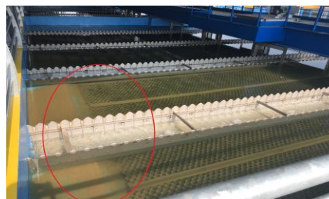
Hình 2.3. Cận ở miệng ống lắng Lamén tại nhà máy nước sông Đuống
