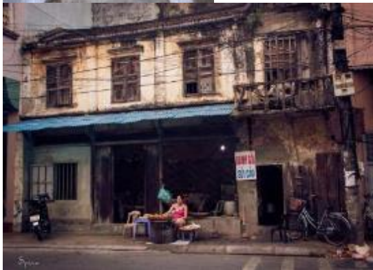
Hình 8. Một số công trình xuống cấp trầm trọng
