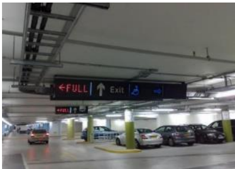
Hình 1. Hệ thống gara trong tầng hầm
