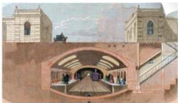
Hình 2. Ga tàu điện ngầm thi công bằng phương pháp đào kín
