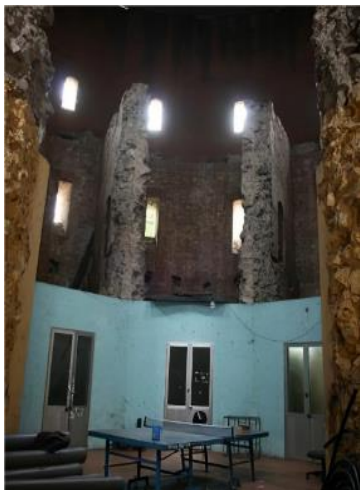
Hình 6. Bên trên các bức tường đỡ bể nước đã bị phá vỡ, các ống nước cũng được tháo bỏ
