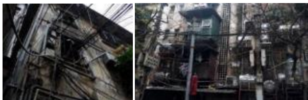
Hình 13. Dây điện chằng chịt trong khu tập thể
