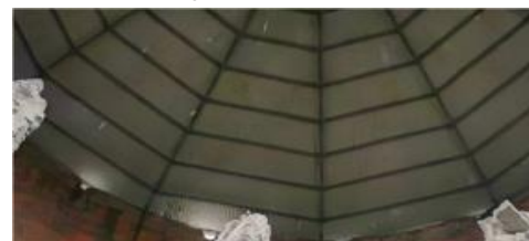
Hình 4. Mái bị thay đổi thành mái tôn
