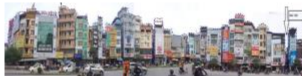
Hình 3. Ảnh chụp thực trạng công trình
