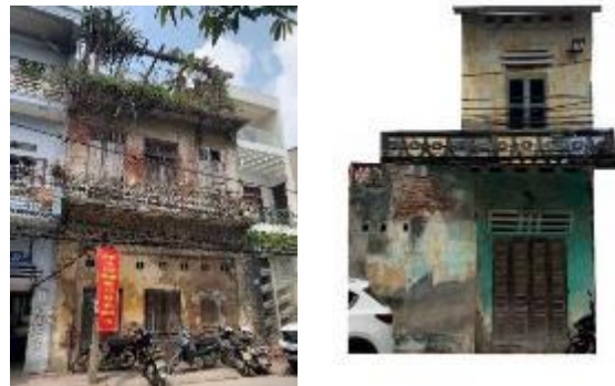
Hình 7. Nhà số 97 và số 75 hư hỏng nặng, và bị bỏ hoang
