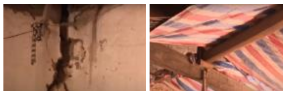
Hình 4,5. Tường nhà nứt, vỡ; mái dột phải dùng bạt che chắn.
