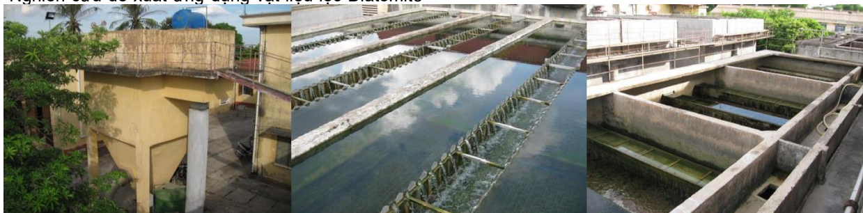
Hình 2.1. Một số công trình xử lý chính của nhóm I (Bể trộn đứng, bể lắng, bể lọc nhanh trọng lực)
