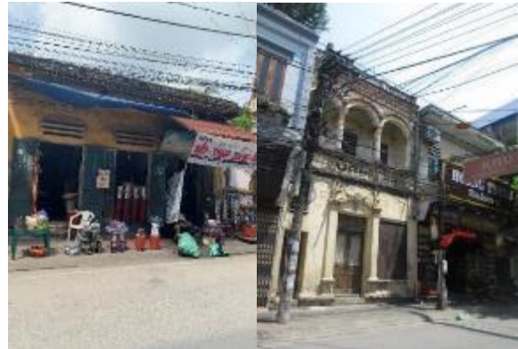
Hình 1. Hiện trạng nhà trong khu phố cổ Thành Nam
