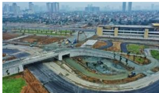
Hình 3. Tường chắn đất có cốt trong đường đua F1
