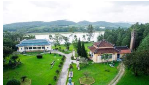
Hình 1. 12. Nhà máy nước Vạn niên Huế
