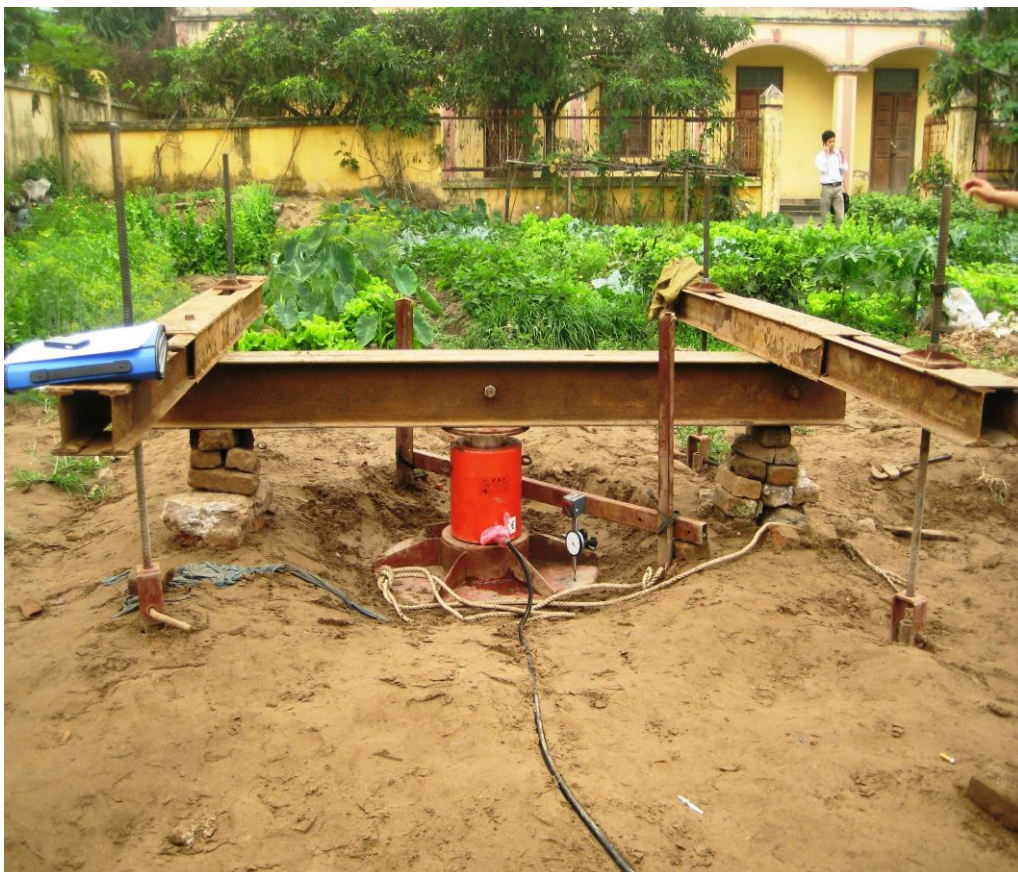
Thí nghiệm nén tĩnh nền tại hiện trường
