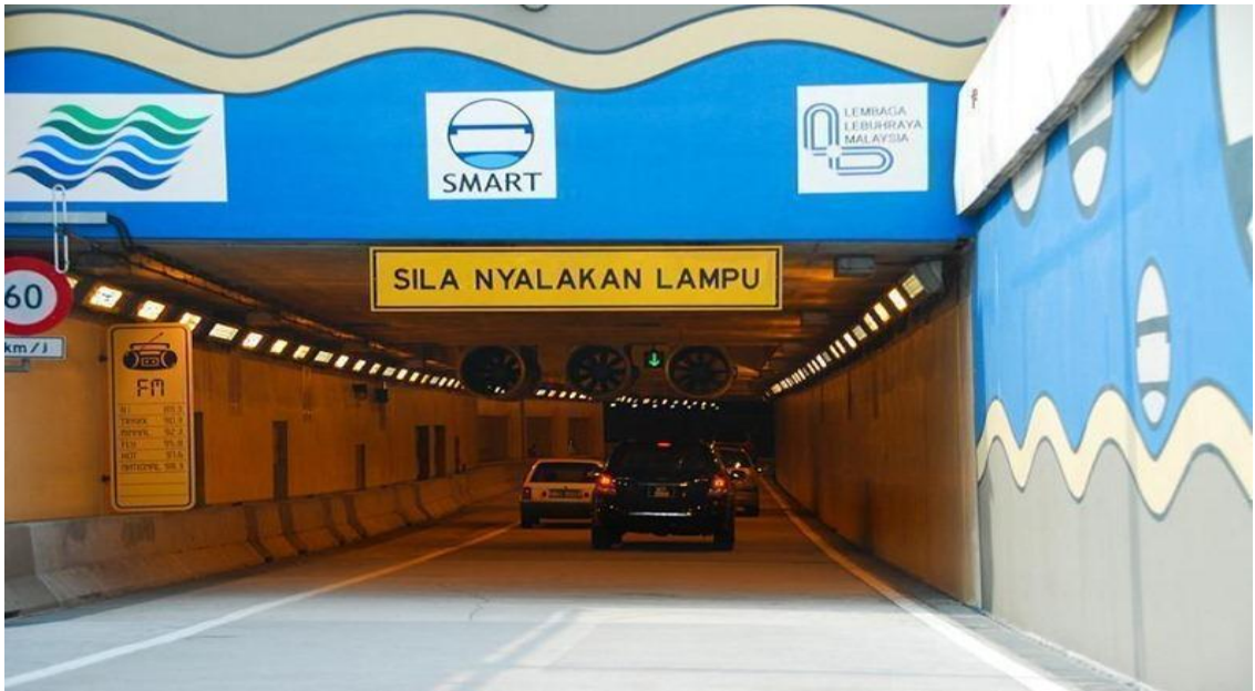
Hình 1.2. Hình ảnh lối vào hầm SMART tại Kuala Lumpur, Malaysia [63]
