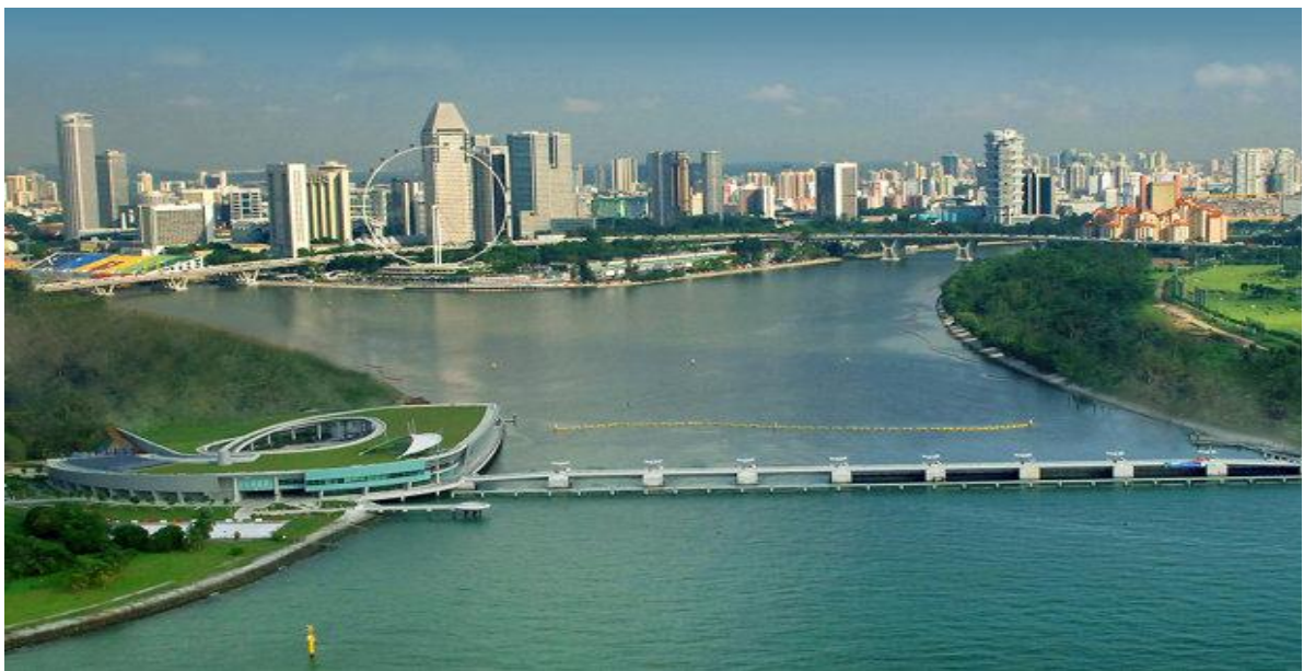
Hình 1.4. Hình ảnh đập Marina tại Singapore - Ảnh: sharesing [63]
