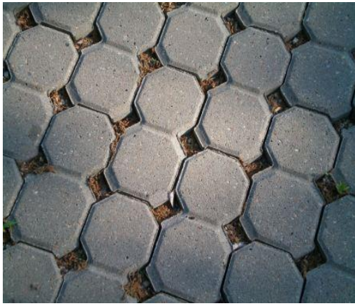
Hình 3.5. Đề xuất sử dụng gạch block có lỗ rỗng để lát mặt đường đi bộ và kết cấu mương thấm nước trong phạm vi ranh giới quản lý hồ điều hòa
