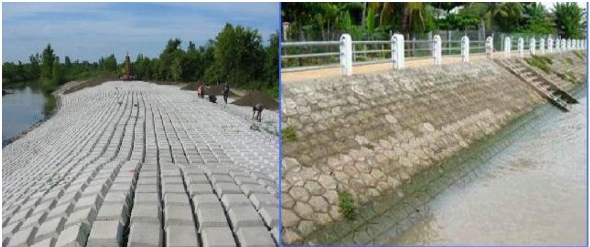
Hình 3.6. Hình ảnh minh họa cải tạo khu vực thuộc phạm vi ranh giới quản lý của hồ điều hòa thành bề mặt thấm nước, lưu chứa nước mưa [63]
