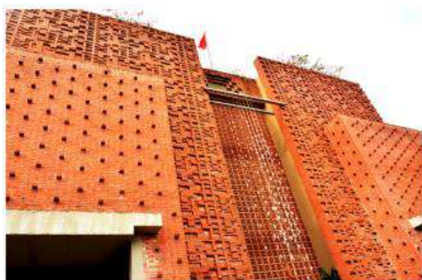
Các chất liệu đất nung được sản xuất từ làng Thanh Hà làm vật liệu chính xây dựng công trình
