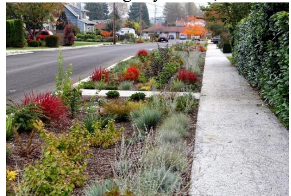
Khu vực lọc sinh học (Vườn thu nước mưa)
