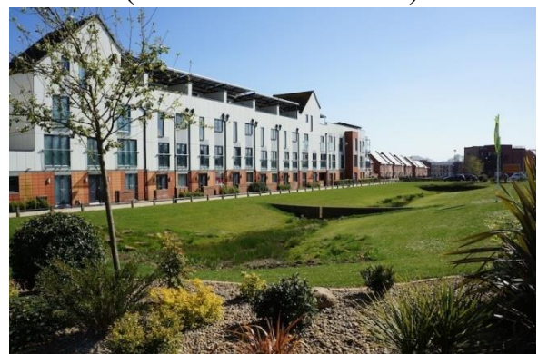
Mương lọc thực vật
