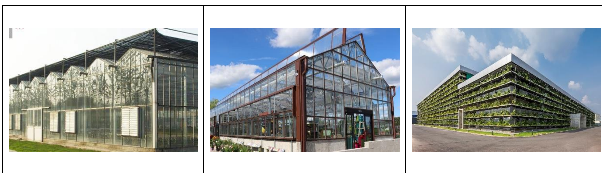
Hình 3.38 Minh họa cách sử dụng màu sắc, chất liệu trên bề mặt công trình
