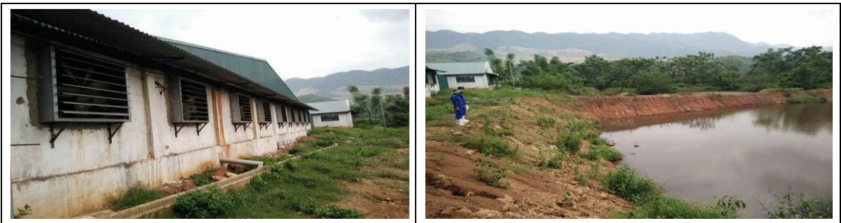
Hình 1.22 Hình ảnh hệ thống xử lý thải của trang trại Chiềng Hặc
