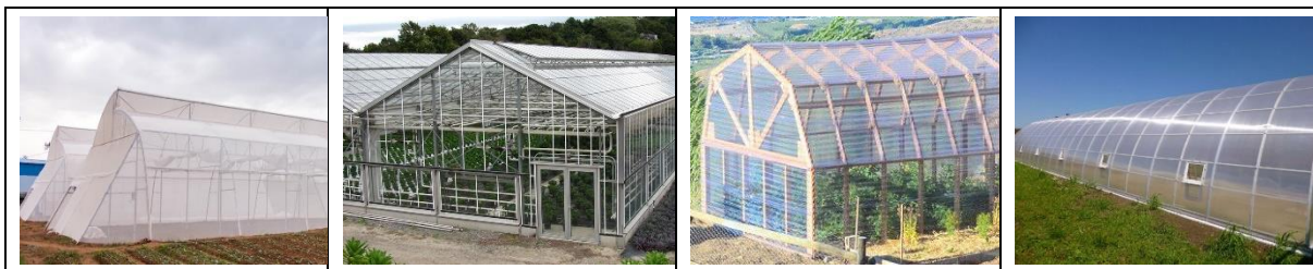
Hình 3.34 Minh họa công trình dùng các loại vật liệu bao che phổ biến nhựa PE, sợi thủy tinh, kính và poly carbonat
