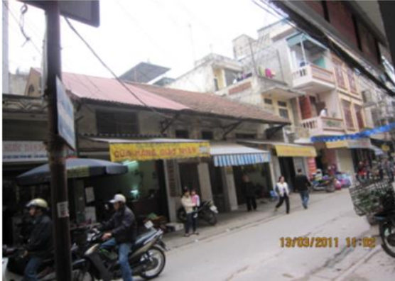
a. Công trình nhà số 23-31 (2011)
