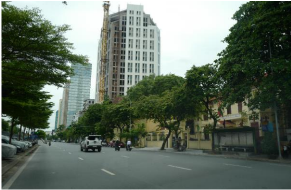
a. Tòa án Hàng Tre xây từ cuối TK 19. Năm 1905, giao lại cho Nha Công chính Đông Dương nay là công trình Viện QHTL và Viện chiến lược PTGT VT, đường ê Trần Quang Khải (2019)
